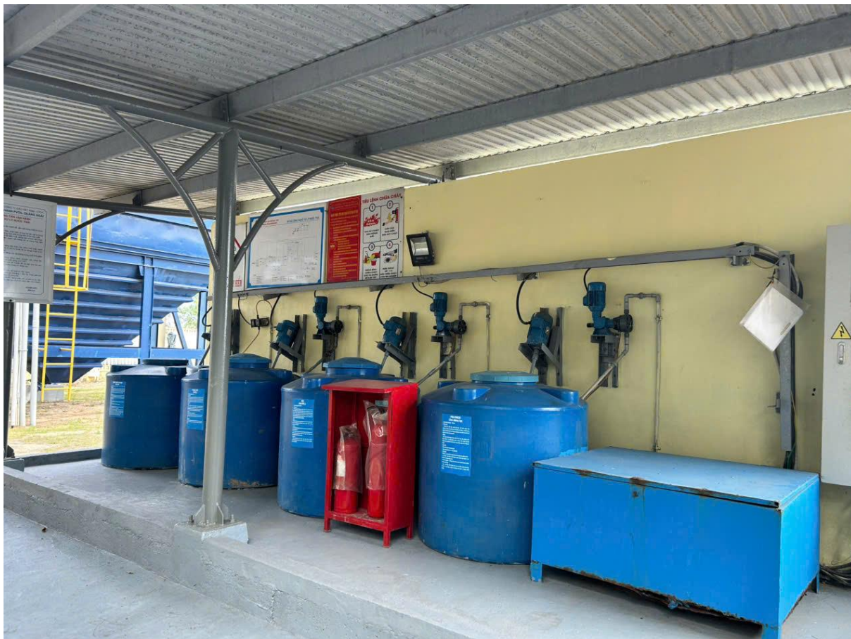
Hình 3. 11. Khu vực hóa chất HTXLNT
