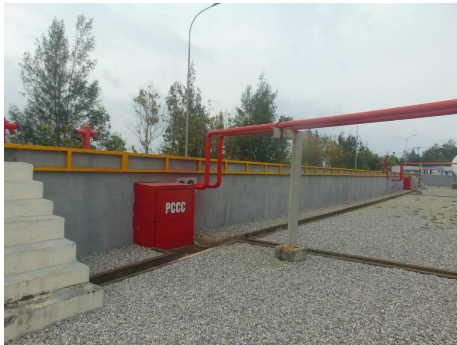
Hình 3. 2. Mương thu gom nước mưa chảy tràn khu vực bể chứa (bên trong đê bao)
