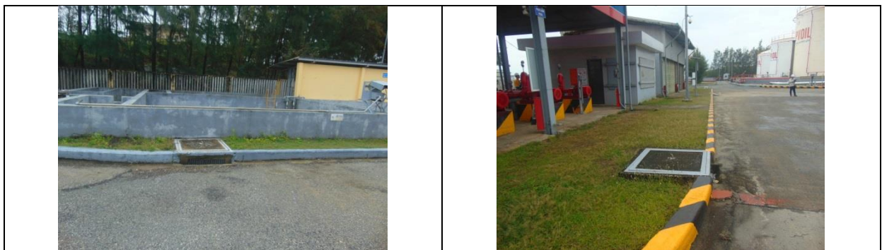
Hình 3. 1. Các hố ga thu nước mưa trong khuôn viên Kho
