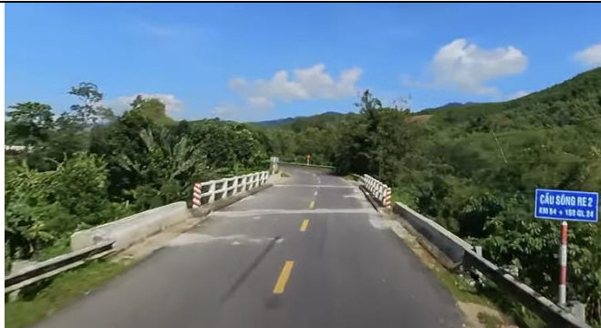
Cầu Sông Re 2
