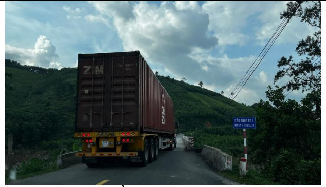
Cầu sông Re 1
