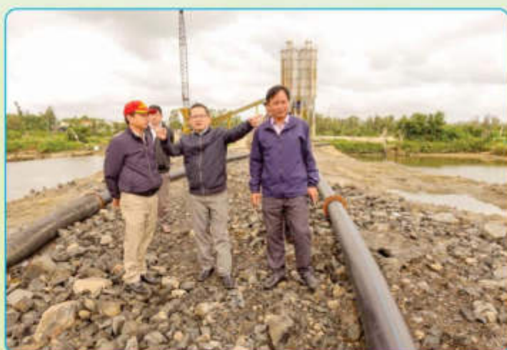
Lãnh đạo Sở Nông nghiệp và Môi trường kiểm tra tiến độ Dự án Nâng cấp, mở rộng khu neo đậu tránh trú bão kết hợp Cảng cá Tịnh Hòa
